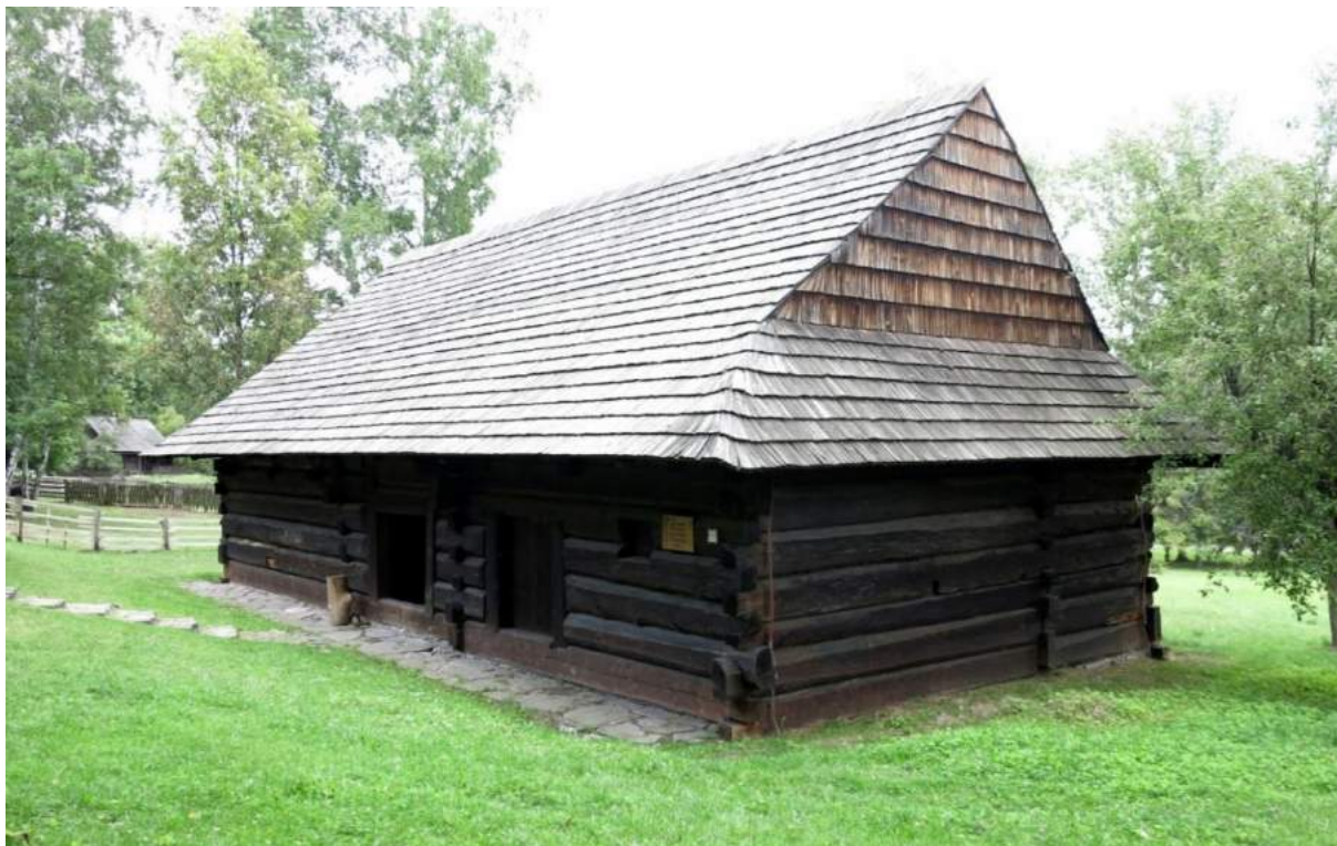
Fot. 63 Chałupa Groniowa z Brennej 1809 r.
