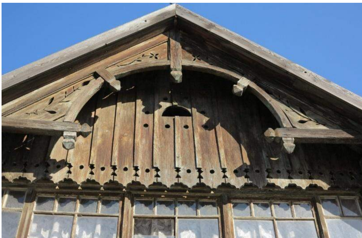
Fot. 51 Jeleśnia 225, Beskid Żywiecki. Detal architektoniczny w postaci mieczy na ścianie szczytowej ganku.
