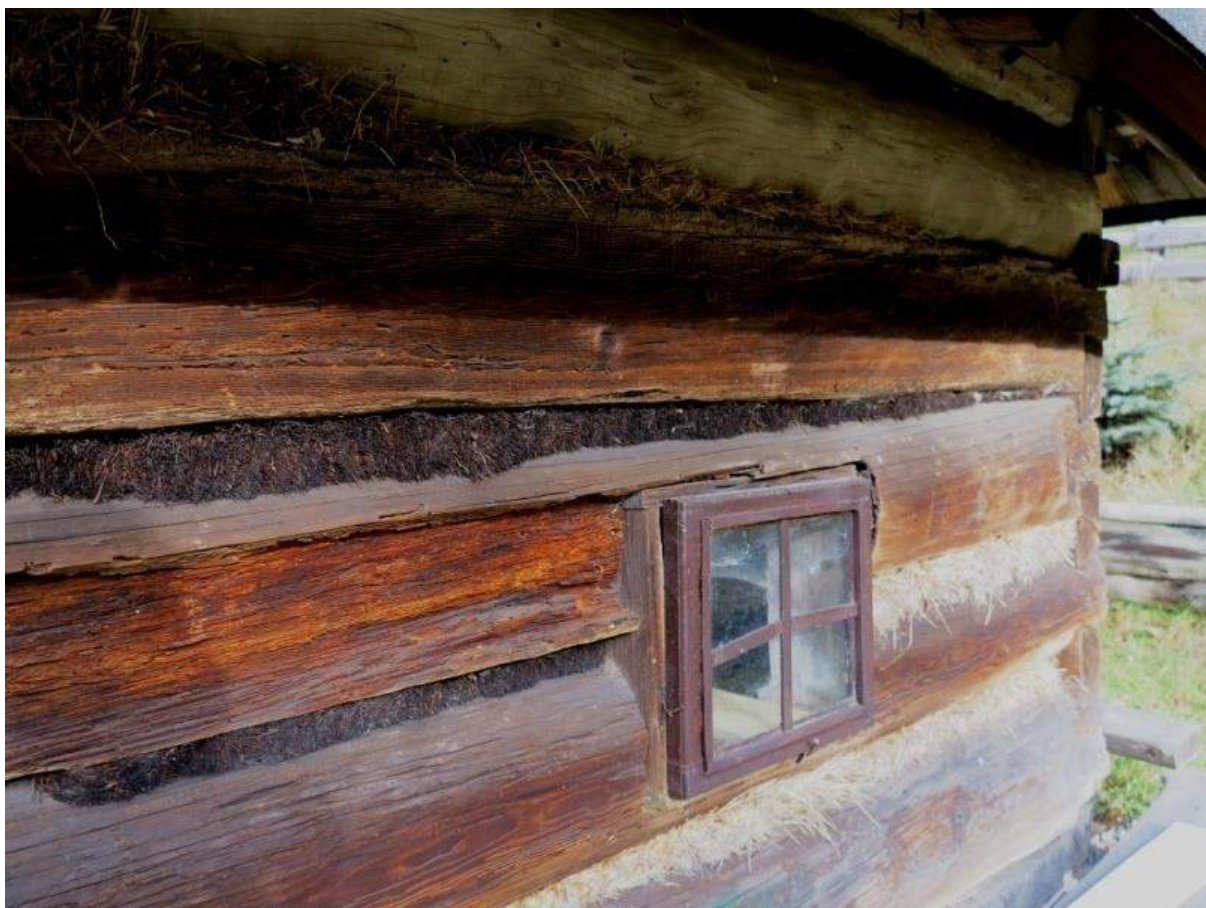
Fot. 8 Wypełnienie przestrzeni pomiędzy bierwionami za pomocą mchu
