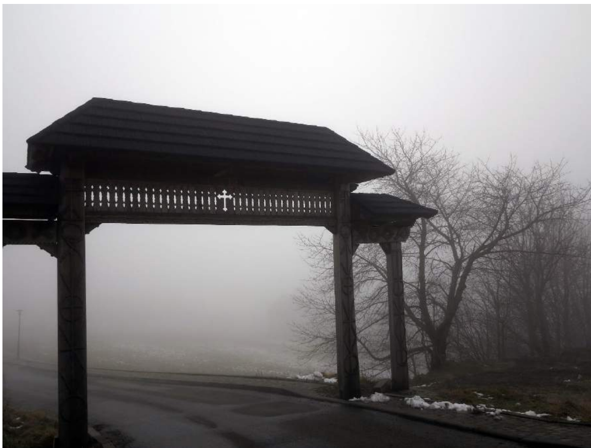
Fot. 16 Fragment Bramy Wołoskiej wybudowanej w 2004 r., Istebna – Złoty Groń, Beskid Śląski
