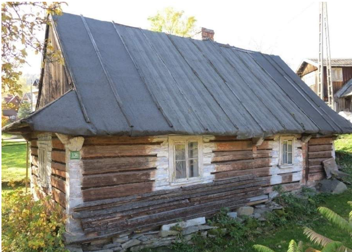
Fot. 56 Korbielów, Beskid Żywiecki Chałupka dwuizbowa z dachem dwuspadowym, przyzbowym
