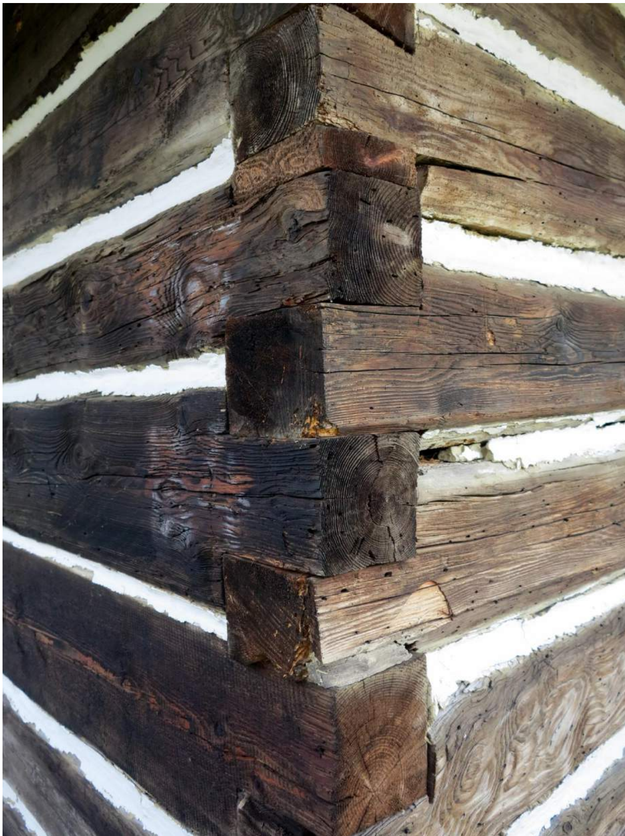
Fot. 32 Naroże domu w skansenie Żywiecki Prak Etnograficzny w Ślemieniu. Wykorzystano wypełnienie przestrzeni pomiędzy balami za pomocą gliny.
