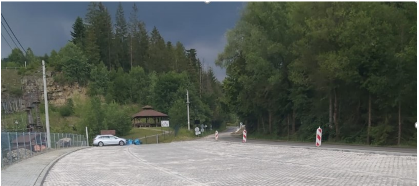
Fotografia z realizácie projektu v obci Ujsoty.
