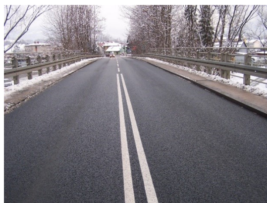
Zdjęcia: Przebudowana droga i obiekty mostowe na terenie Powiatu Żywieckiego
